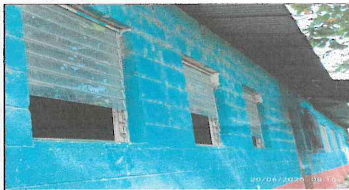
Sustitución de 6 balcones en salón de primero primarian
