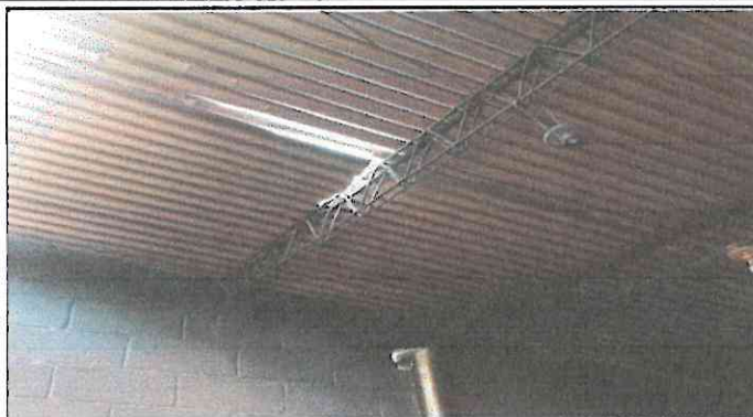
Sustitución de lámina acanalada por lámina troquelada en area de cocina, mantenimiento a estructura de soporte de metal, lijado y pintura y sustitución de 2 balcones.
