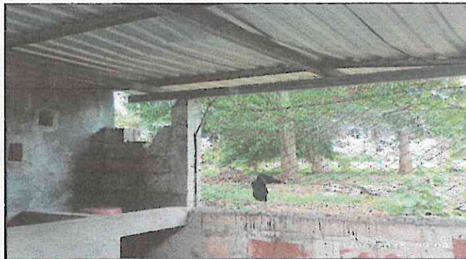
Sustitución de lámina troquelada por lámina troquelada y sustitución de estructura de soporte de metal por metal
